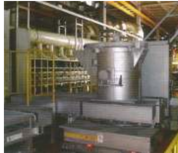
Metal Fundido - Carro de Transferência
