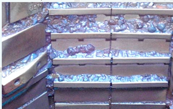
Revestimento com Stone Box
